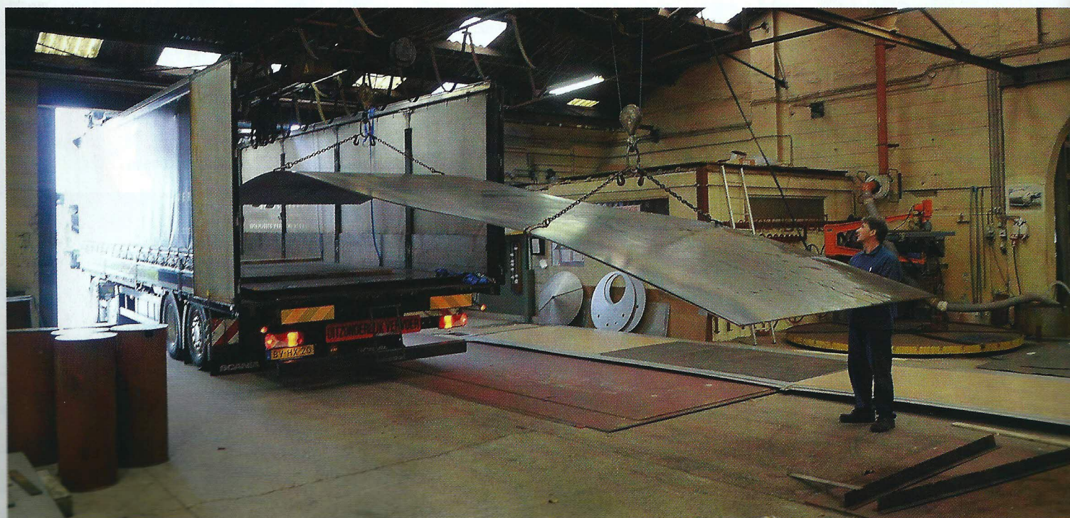
Concentratie vereist: het lossen van de tien meter lange staalplaten.
